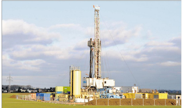
EIN GROSSER BOHRTURM und ein Arbeitscamp sollen noch in diesem Jahr auf einem Gelände im Kammerforst bei Graben-Neudorf errichtet werden. Die Firma Rhein Petroleum plant dort Probebohrungen nach Erdöl. Foto: pr
